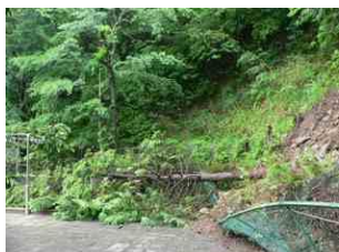
がけ崩れ現場
