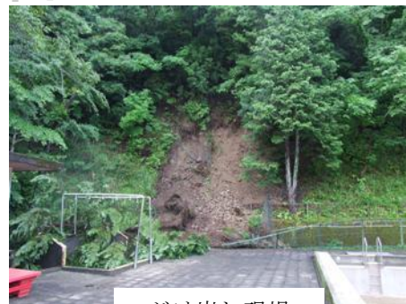
がけ崩れ現場
