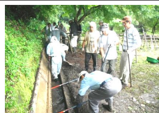
側溝の土砂の撤去
